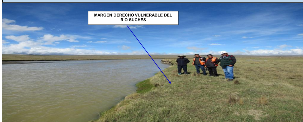
FIGURA N°01: TRAMO CRÍTICO EN EL RIO SUCHES MARGEN DERECHA YA QUE SE TIENE QUE REQUIERE DE ENCIMADO POR EL DESBORDE CONSTANTE QUE SE PRODUCE EN ESTE TRAMO DEL CENTRO POBLADO DE SUCHES, DISTRITO DE COJATA
